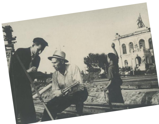
Альбом «Строительство новой трамвайной линии в Воронеже 1954 год» 1954 г.
